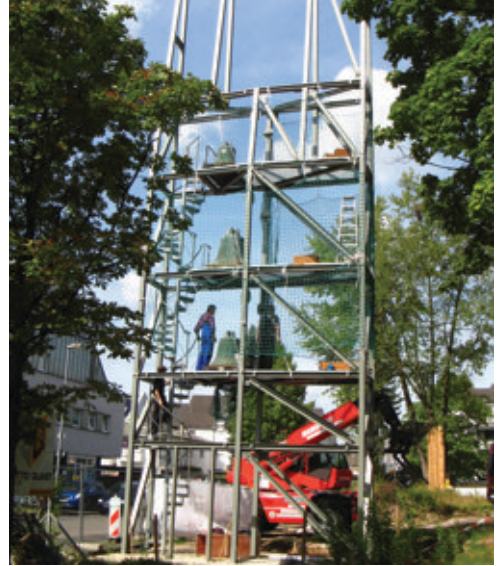
Der neue Glockenturm in der Bauphase. (Foto: A. Ginsberg)
