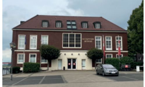
Das Haus der ehem. Schifferbörse.
