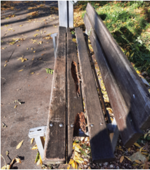
So sieht eine beschädigte Bank aus.
